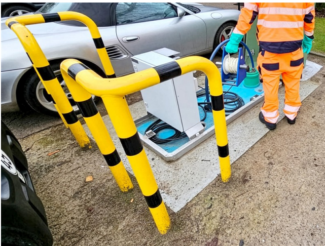
Darstellung einer geöffneten Brunnenhaube NACH der Umbaumaßnahme
