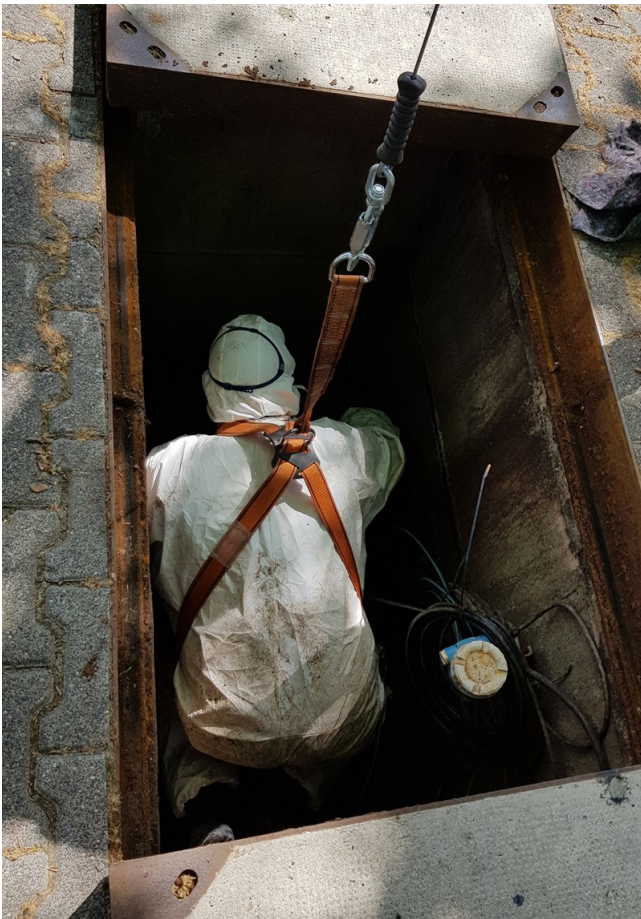
Altzustand: Beengte Platzverhältnisse bei Arbeiten im Brunnenschacht
