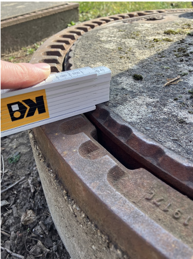
Darstellung der maximalen Deckelanhebung von 2 mm
