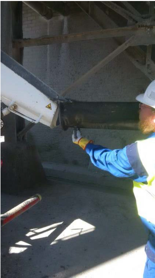
Verlängerung wird eingehakt
