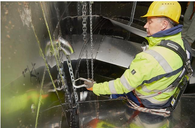
Die Ketten des Sicherungssystems werden für die Kontrolle und Reparaturarbeiten in den Behälter eingelassen und der Mitarbeiter kann sich durch Einhaken in die Kettenstücke in dem jeweiligen Behälterabschnitt sichern.
