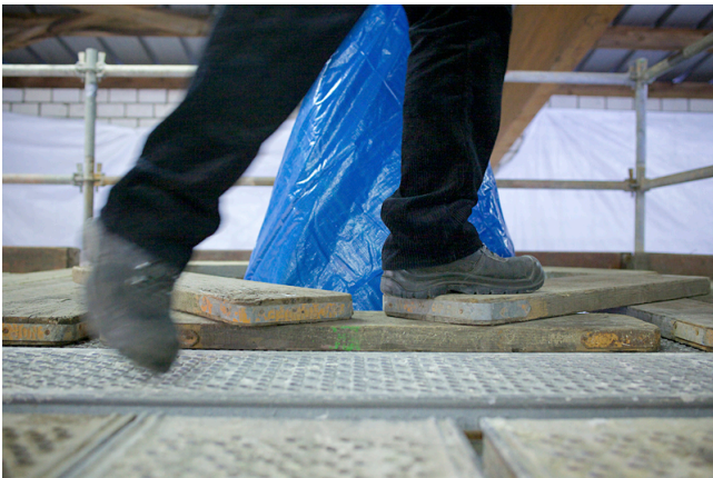
Bisher ein Schwachpunkt beim Einsatz von Systemgerüsten: Bei Aussparungen oder runden Baukörpern werden Bohlen zum Abdecken von Öffnungen eingesetzt.
