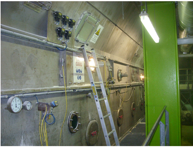
Zugangsöffnung am Wirbelschicht (bisher H 400 x B 550 mm)
