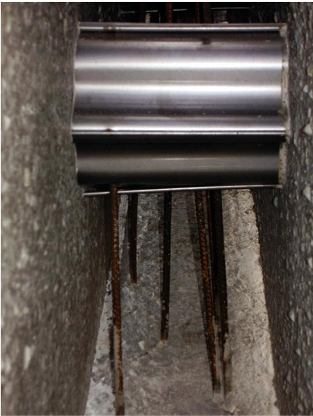
Die Bewehrung aus der Bodenplatte wird entweder durch die Welle abgelenkt oder durchstößt das Blech.
