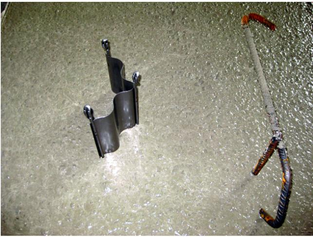
Das Versetzen der Doppelwände erfolgt mit Verlegeankern.
