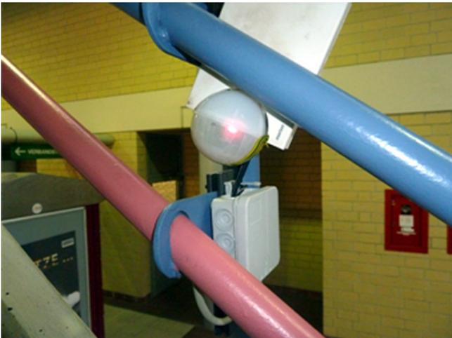
Funktions-Prinzip: Passiv - Infrarotsensoren erfassen den Treppenbenutzer
