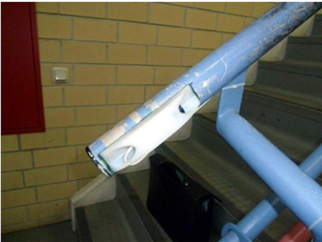
Funktions-Prinzip: Infrarot- Lichtschanke erfasst den Handlaufgebrauch
