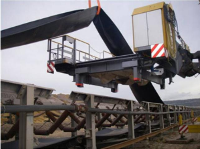
An der zu reparierenden Stelle hebt ein Kran den Obergurt an. Ein Kopflader setzt die Reparaturplattform auf dem Bandgerüst ab.
