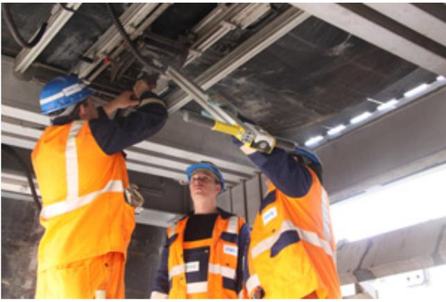
Einbau des Fräswerkzeugs in die Zwangsführung an der Gurtunterseite. Arbeiten in gebückter oder kniender Haltung sind jetzt passé, ebenso das belastende und risikoreiche Fräsen der Bandoberfläche von Hand.
