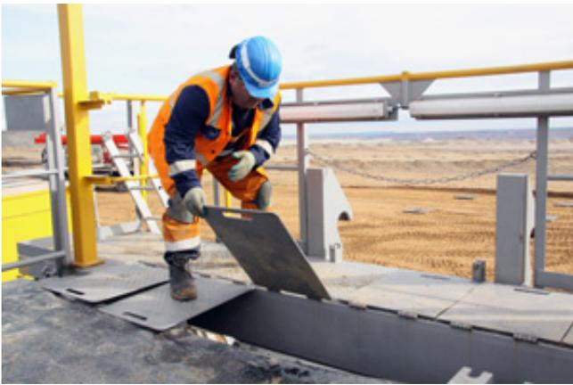
Spezielle Abdeckungen überbrücken den Spalt zwischen Gurt und Laufsteg.
